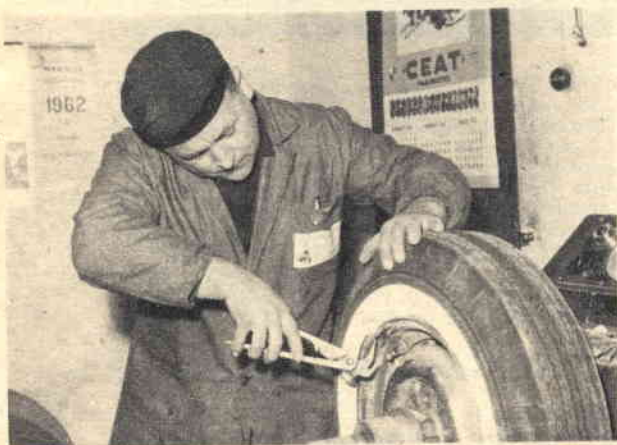
Fig. 1 - Applicata la ruota sulla macchina di verifica, prima di controllare l'equilibratura della stessa, è necessario togliere gli eventuali piombi applicati in precedente equilibratura.
